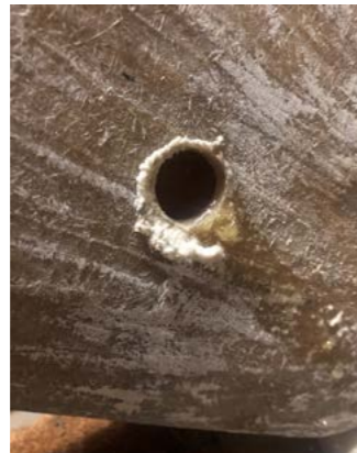
Gaten boren in het roer
